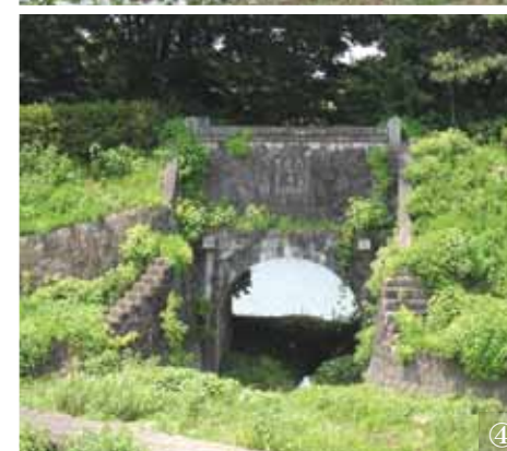
①波岩と新平戸橋 ②中の島 ③地蔵 ④樋門
