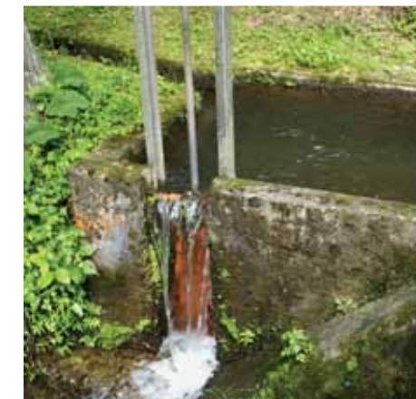
用水（取水口） Irrigation canal (intake)
