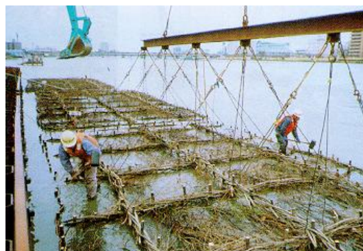
図 79：粗朶沈床工
