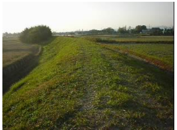
図65：豊川市三谷原町中の霞堤
