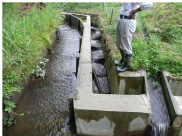
田野沢地区 (水田と水路を結ぶ魚道の設置)
