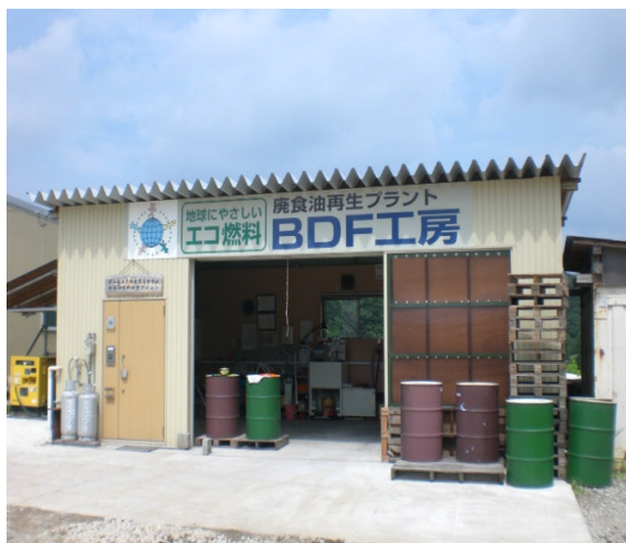
廃食油再生プラント場
