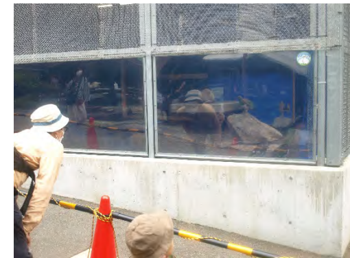
コーンとバーで人止め柵を設置
