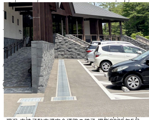
現況 車椅子駐車場安全通路の様子 撮影2025年5月
