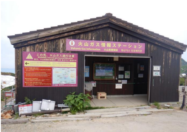
火山ガス情報ステーション (監視員詰所)
