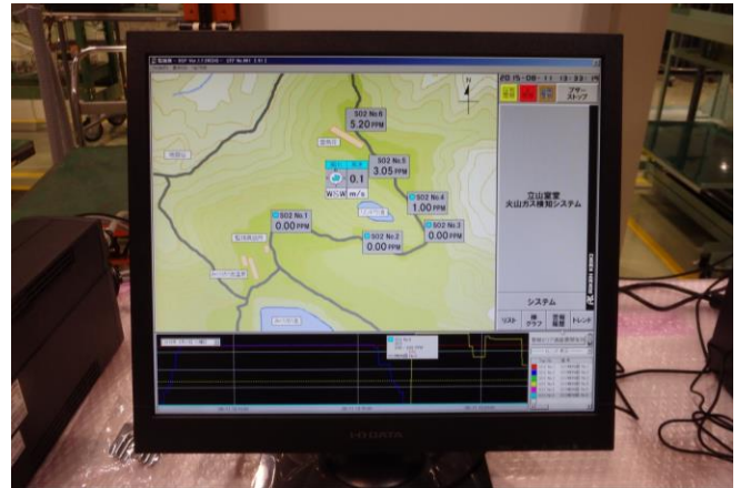
立山センターにおける監視モニター
