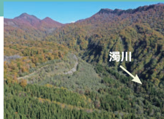
今池湿原の南側の地すべり跡地 アンカー工や杭打工などの対策が行われました。
