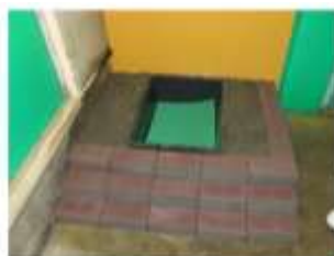
プラ箱の底には水抜き用の穴があけてあり、その上にトリカルネット 2 枚とタオルを敷く。その上へ赤玉土（1402 袋）を敷き詰め、踏みつけてよく固める。（赤玉土深さ 10cm 程度）
