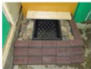
インターロッキングで囲んだ内側にプラ箱を配置し、隙間には自然石と川砂を敷き詰める。プラ箱上の板は、ハイマツ枝を釘で打ち付けるのに使用、L 字金具で背面の板と固定。（産卵場所 41×37cm）
