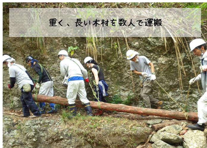
ロープ・スリング・カラビナ・滑車などを使い、運搬や移動の方法を覚えておくと丈夫な木材を使い、頑強な施工物を作る事ができる。また、施工資材は普段から倒木などを把握しておき、資材量や運搬に必要な労力などを割り出しておく事が重要である。
