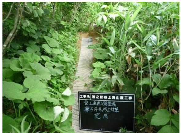
ゴムマット設置後(写真:永井建設提供)
