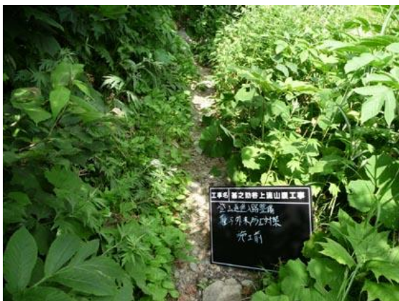
ゴムマット設置前(写真:永井建設提供)
