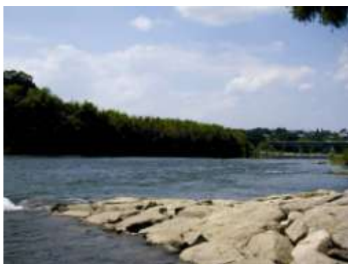
近自然工法により整備された水制工
