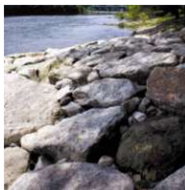
近自然工法により整備された水制工
