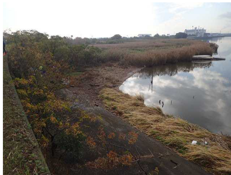
ごみ撤去作業後（撤去作業場所②）
