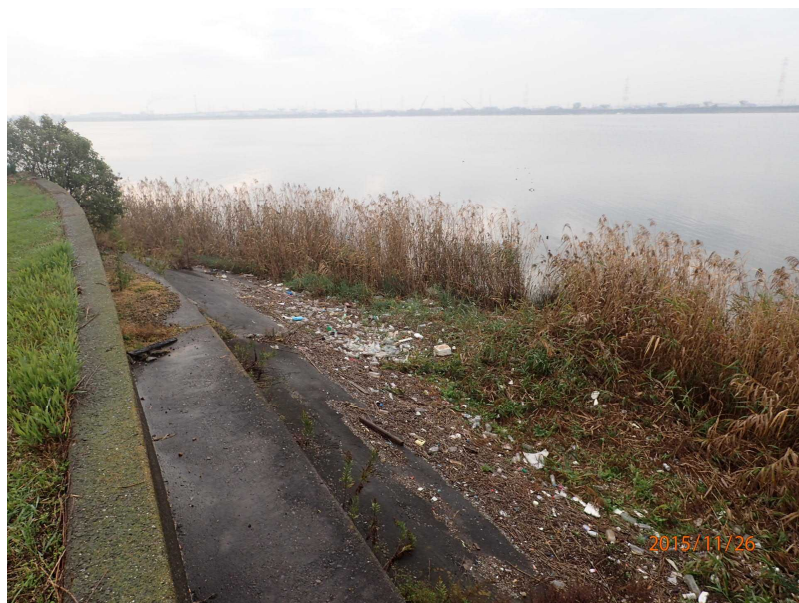
ごみ撤去作業前（撤去作業場所①）
