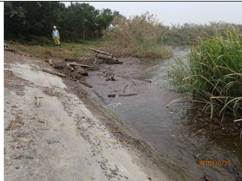
ごみ撤去作業後（撤去作業場所②）
