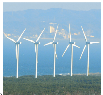
渥美風力発電所
