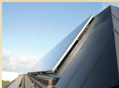
太陽光発電(安城市)
