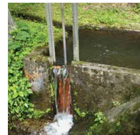
用水（取水口） Irrigation canal (intake)
