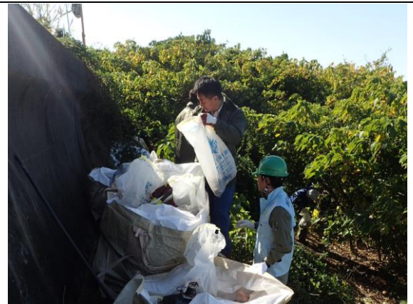
ごみ撤去作業（戸田茶屋排水機場南）
