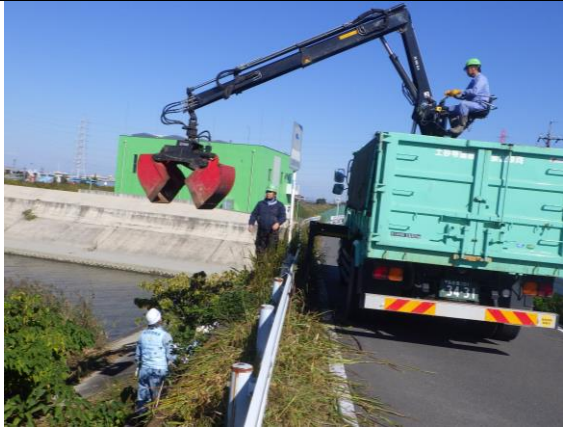
ごみ撤去作業（戸田茶屋排水機場南）
