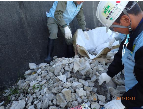
ごみ撤去作業（戸田茶屋排水機場南）
