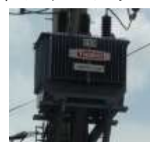
高効率アールパス変圧器 (日立金属。ベトナム)
