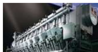
コージェネレーションシステム (トヨタ自動車インドネシア工場) (新日鉄住金エンジニアリング。タイ)
