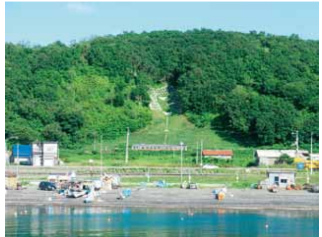
土砂崩壊防備保安林(北海道増毛町)
