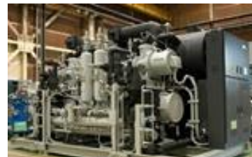
高効率冷凍機 (前川製作所)
