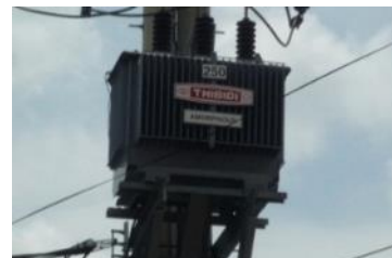
高効率アムス変圧器 (裕幸計装) アムス金 属：日立金属製
