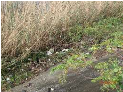
ごみ撤去作業前（サンビーチ日光川横）
