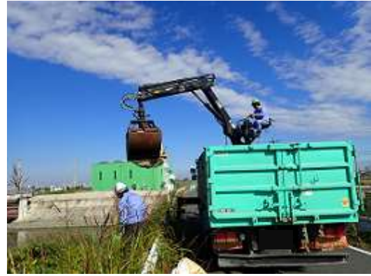
ごみ撤去作業（戸田茶屋排水機場南）
