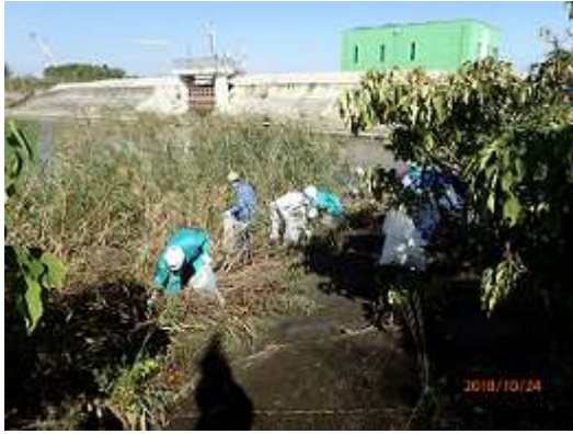
ごみ撤去作業（戸田茶屋排水機場南）
