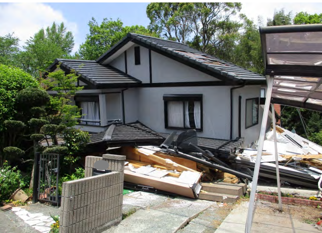
住宅の被害 (新耐震以降でも全壊の被災)
