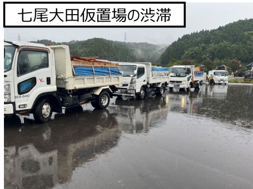
七尾大田仮置場の状況
