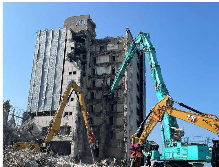
【特殊な重機による大型旅館の解体】
