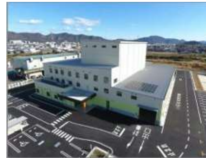
容器包装リサイクル推進施設
