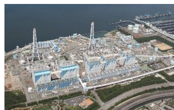
碧南火力発電所
