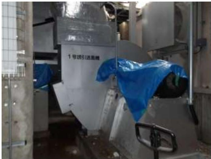
電動機の雨漏り養生
