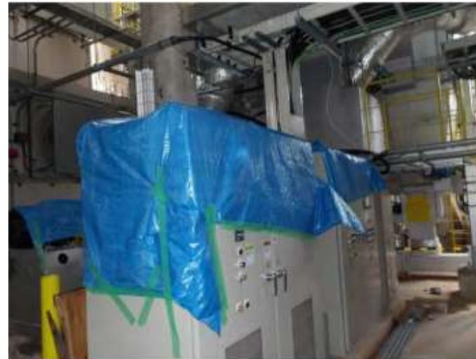
制御盤の雨漏り養生
