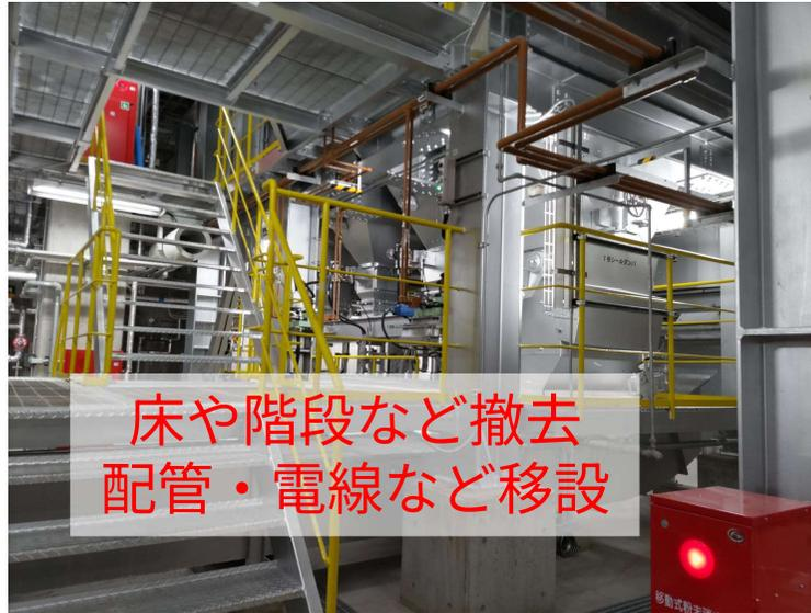
井桁と干渉する床・階段など撤去
