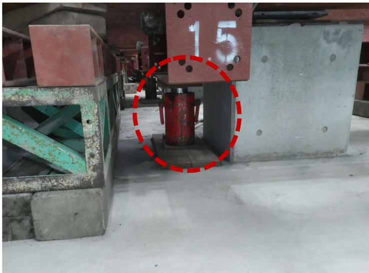
100ton油圧ジャッキ 6箇所設置
