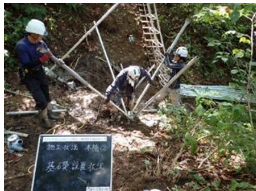
写真2 簡易基礎工法
