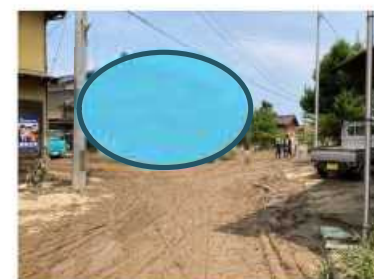
被災状況写真
