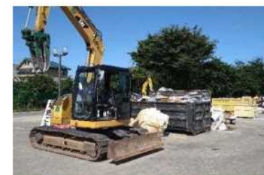
災害廃棄物仮置場写真 こまつドーム第2・第3駐車場 途中状況
