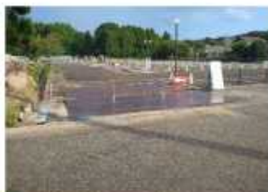
災害廃棄物仮置場写真 こまつドーム第2・第3駐車場 整備後(第3駐車場)
