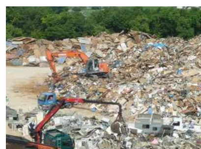
災害廃棄物の仮置場の管理
