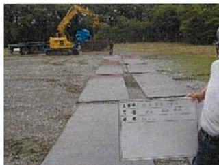
③敷鉄板搬入布設
