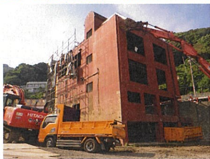
内装及び外配管等撤去
