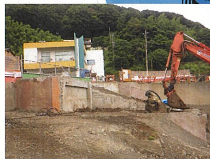
解体（残地物あり）
