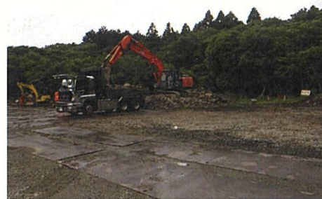
コングラの 搬出作業
