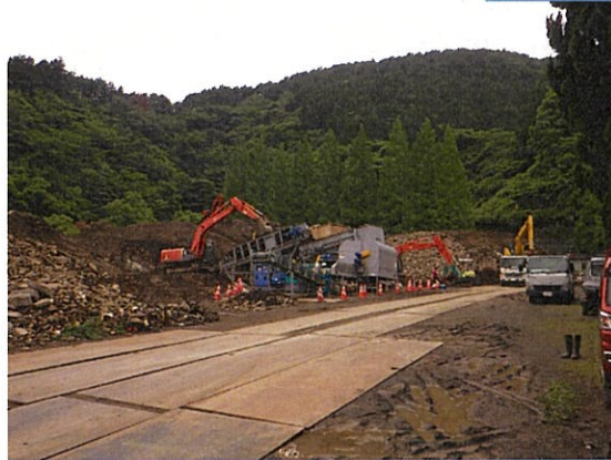
旧小嵐中学校土砂選別作業
