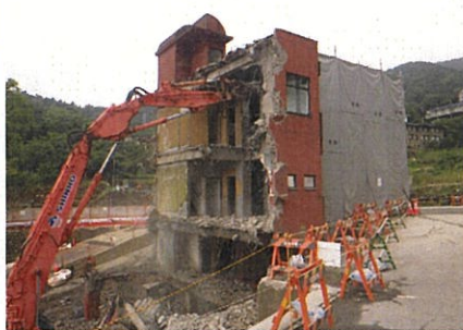
RC家屋兼店舗解体
