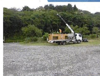
④エントハウス設置 (仮設トイレ、倉庫含)
