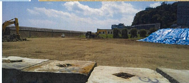
R3.8.31 海側が選別完了
