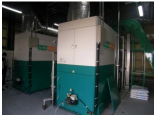
チップボイラー
