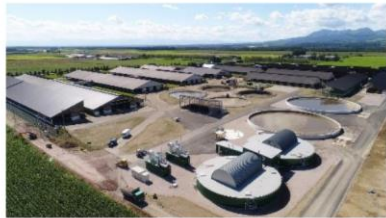
バイオガスプラント
