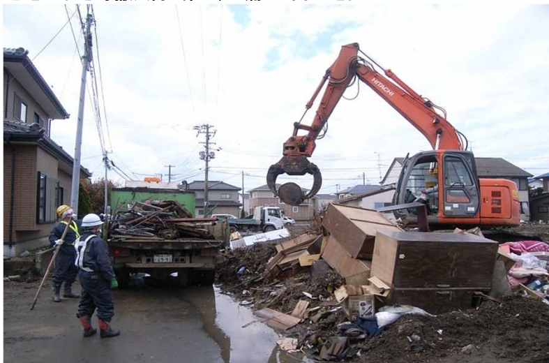
宅地がれき等撤去隊 第2班 蒲生・岡田地区
