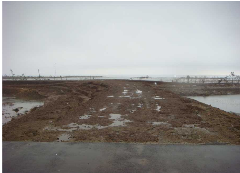
被災状況写真
