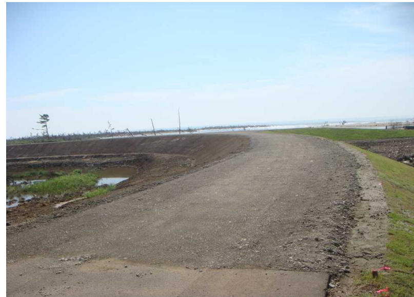
暫定復旧完了写真
