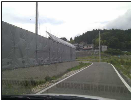
防音・防じん壁の設置
