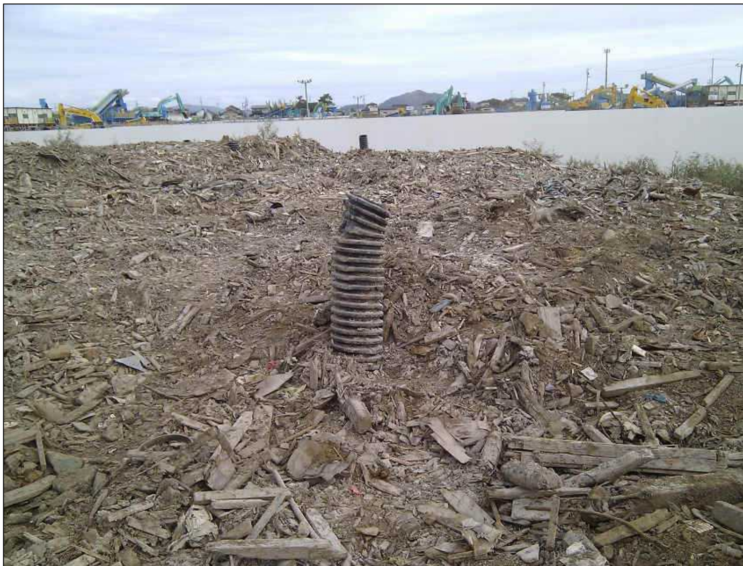
※火災防止のためのガス抜き管
