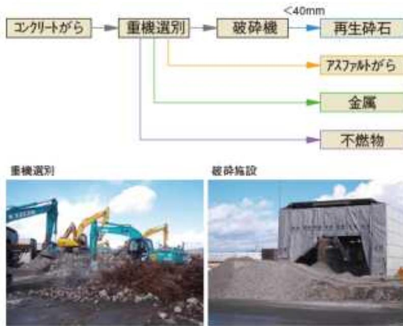
コンクリートがらから鉄筋などを取り除き、0～40mmの大きさに破碎します。
