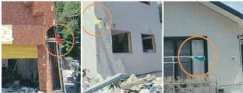
写真 3-1 誤解体防止のための3色の旗
