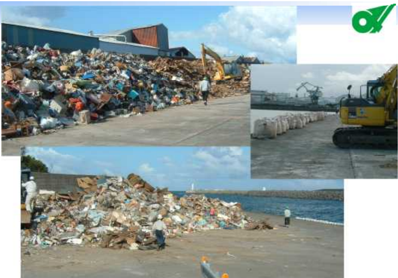
鵜殿港の仮置場
