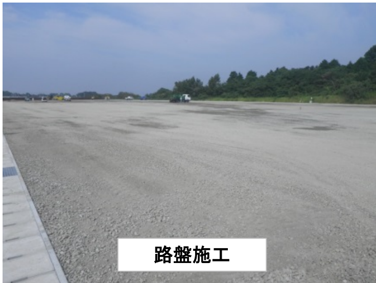
仮置ヤードの舗装
