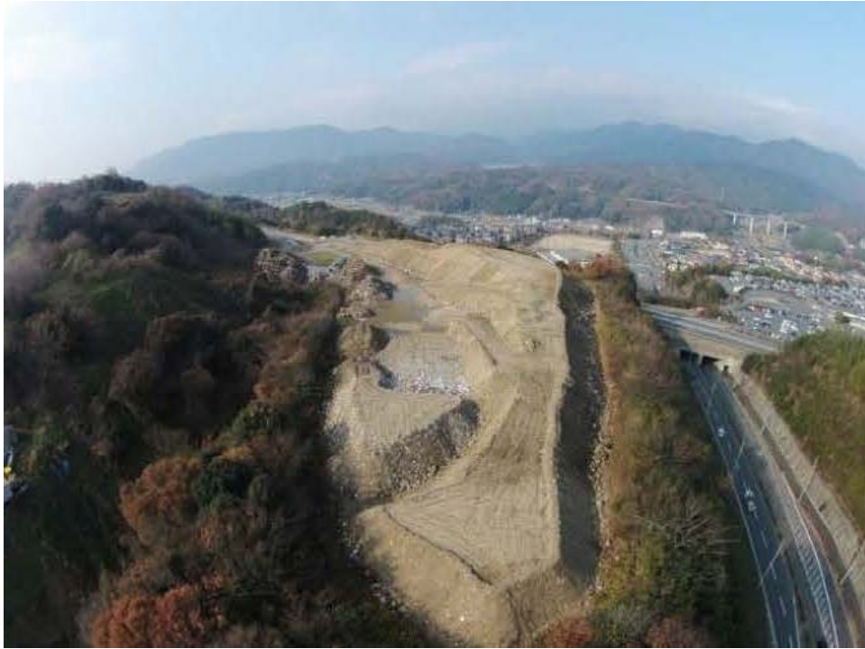
消防の訓練施設における空き地を仮置場にした事例。
