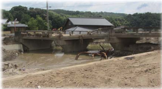
橋脚の破損による交通傷害
