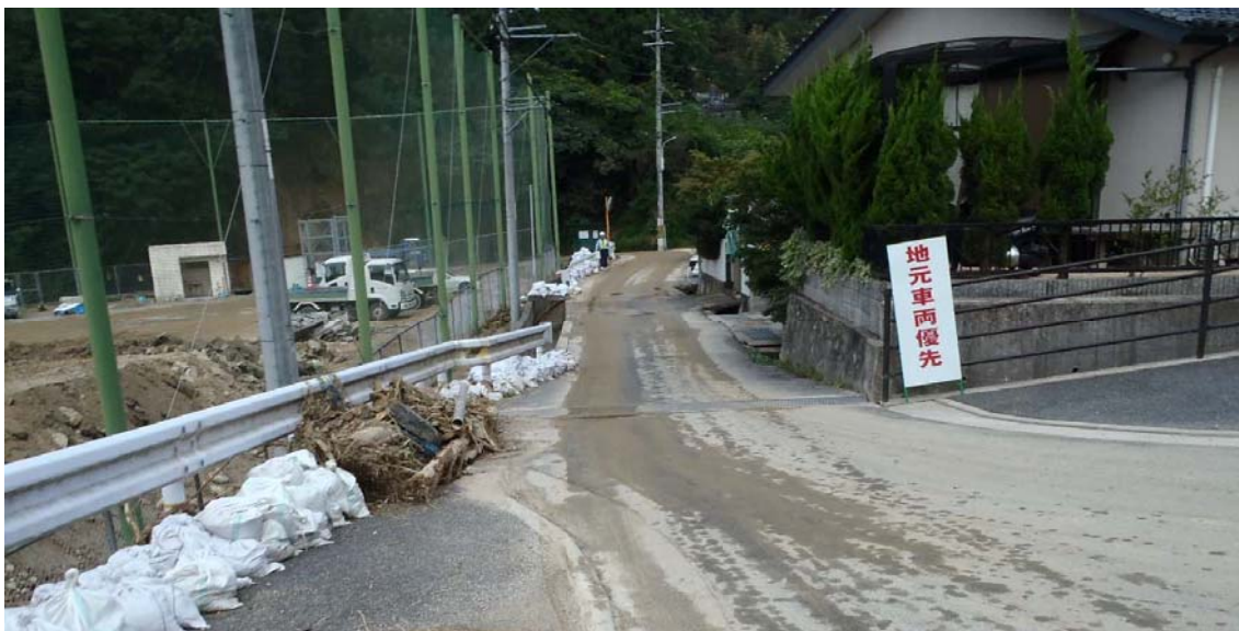
住宅の近くに設置した仮置場の事例。 道路清掃や運搬時間、優先車両等への配慮が必要。
