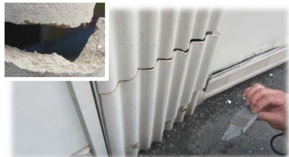
石綿含有建材の破損・露出
