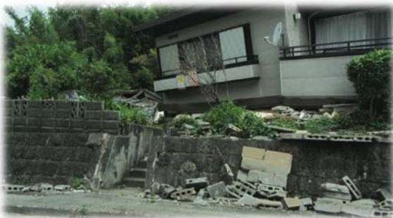
擁壁やブロック塀の倒壊
