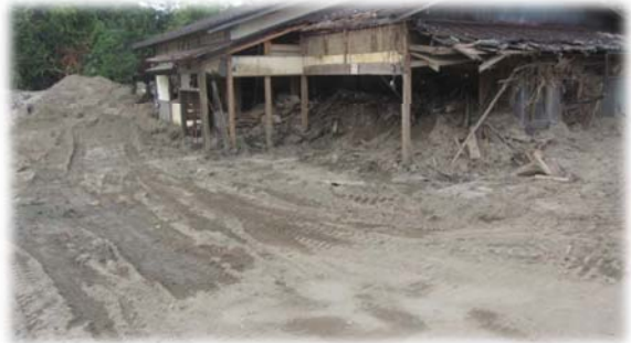
家屋への土砂の流入
