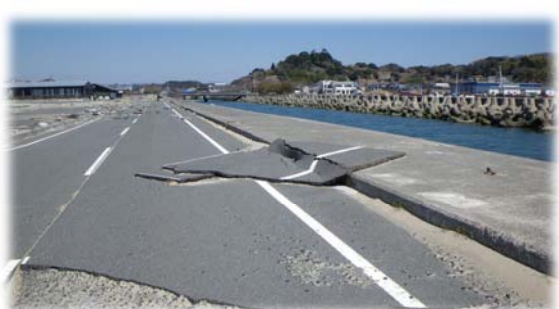
アスファルトがめくれる
