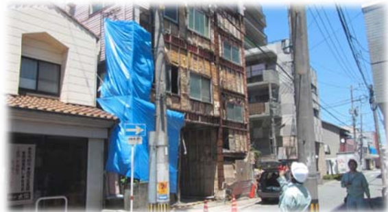
外壁落下と余震での二次災害対応
