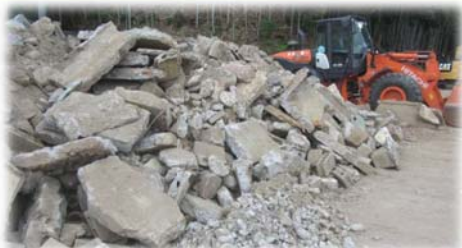
コンクリートくずの仮置きの様子
