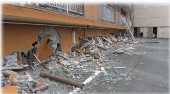
1階部分の崩壊（残壊物は移動しない）
