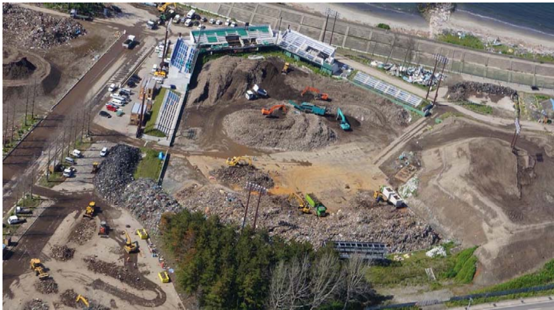
被災して使用できなくなった野球場を仮置場にした事例。
