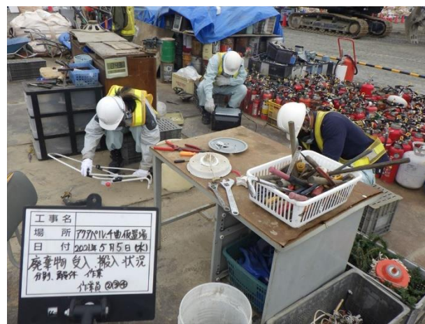
可燃物解体選別作業
