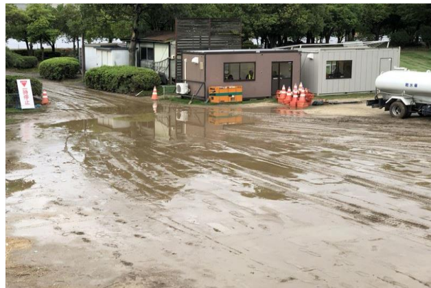
水溜まりが出来て 車両走行不可
