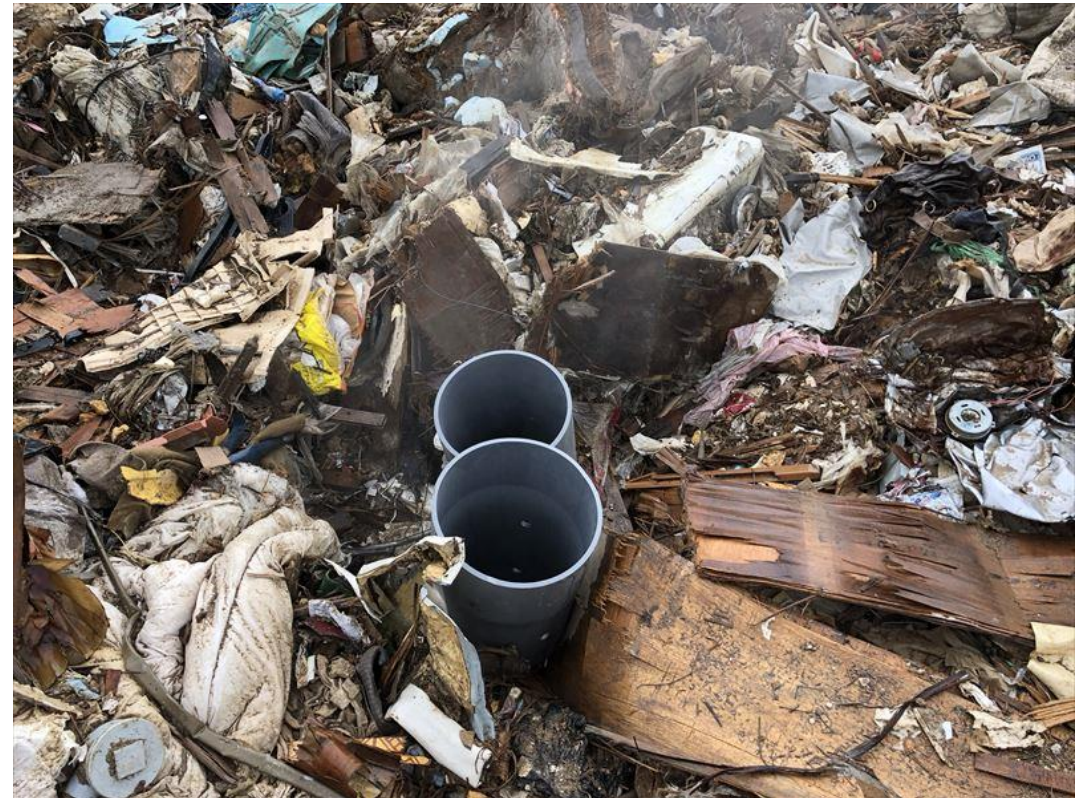
ガス抜き管設置状況
