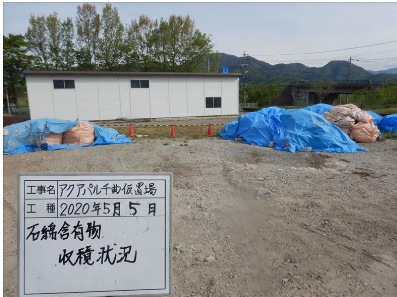
石綿含有物（疑い）
