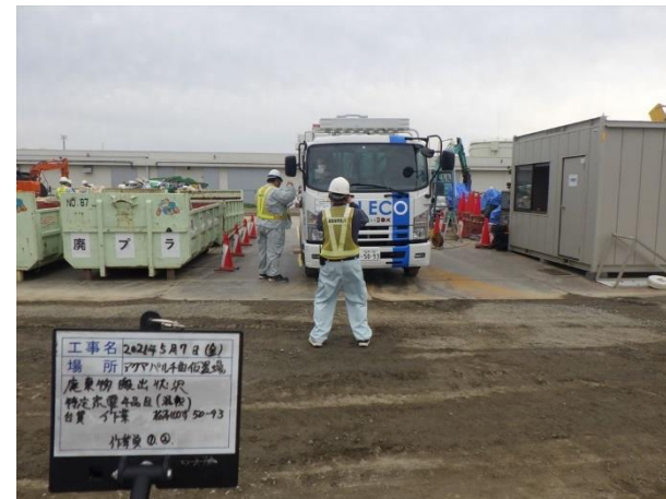
搬出物台貫計量作業
