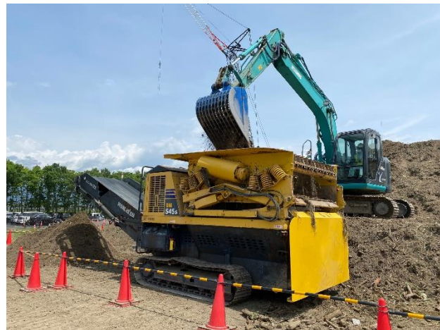
土砂がれき篩い作業
