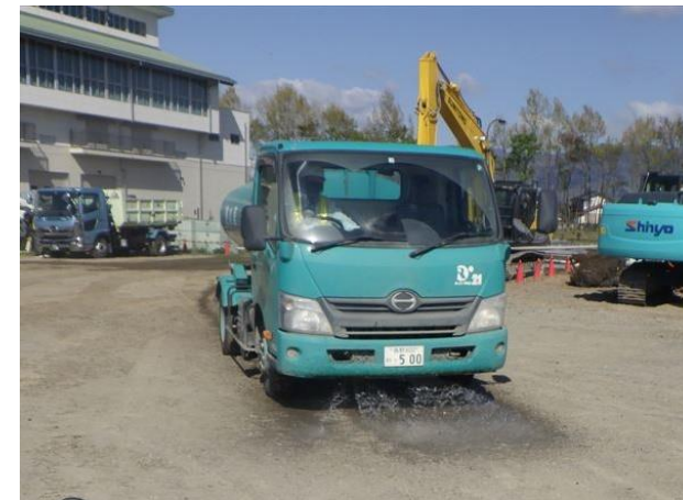
場内散水作業
