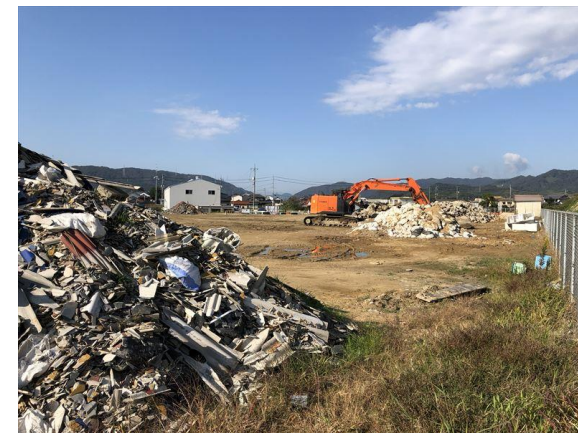
真備浄化センター1次仮置場
