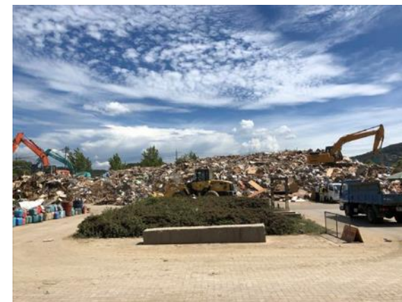
マービーふれあいセンター1次仮置場
