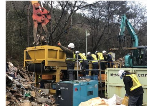
手選別コンベアーによる 可燃物の選別
