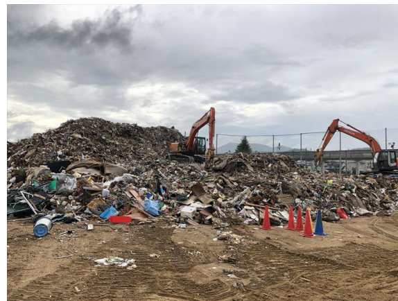
真備中学校1次仮置場
