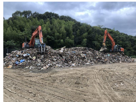
増原公園1次仮置場
