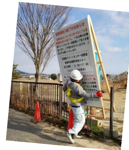
仮置場終了の案内看板設置状況
