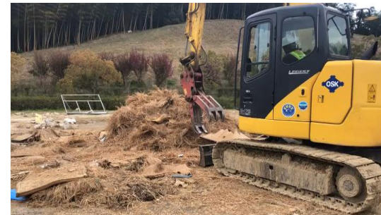
重機による畳の破碎（-300程度）
