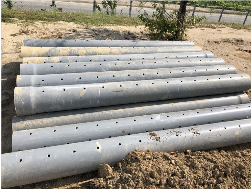
ガス抜き管（有孔管）
