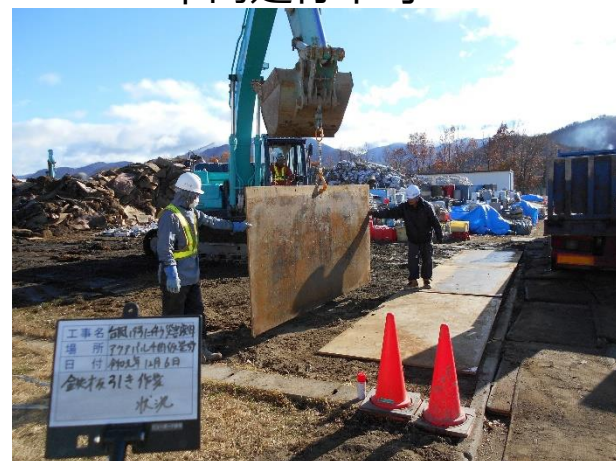
鉄板敷設状況
