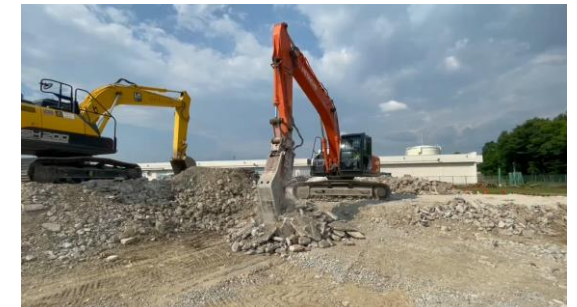
重機によるコンガラの破碎
