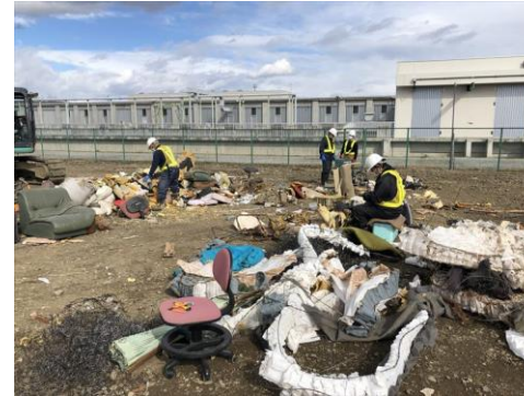
作業員によるソファ、 ベッドの解体
