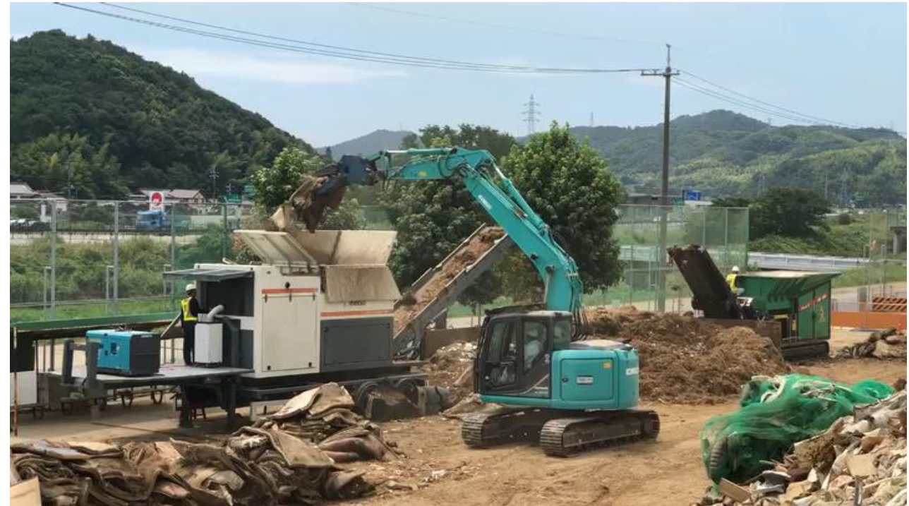
破碎機による畳の破碎 (-300)
