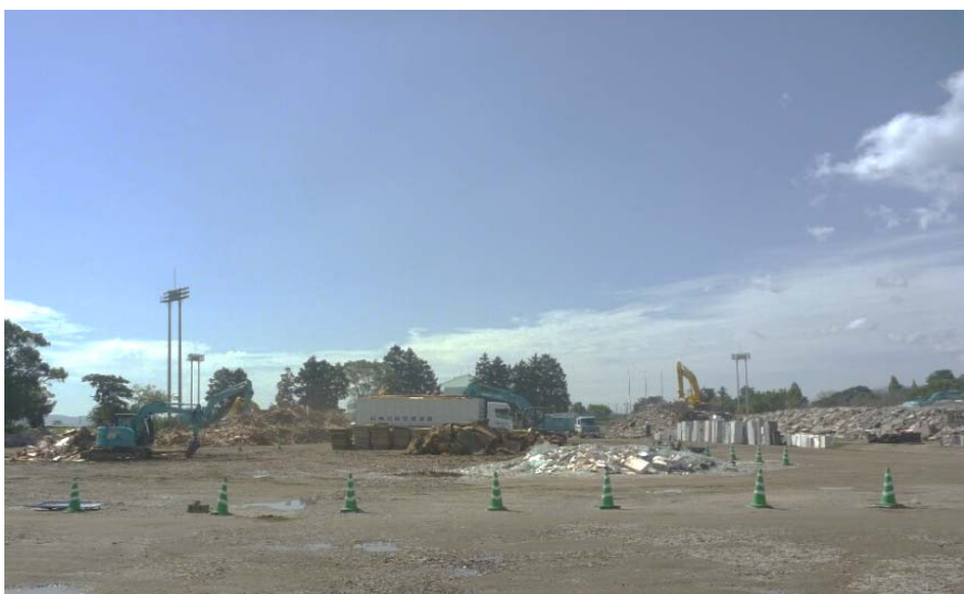
益城町の一次仮置場(益城町中央小学校跡地)の様子(10/6時点)
