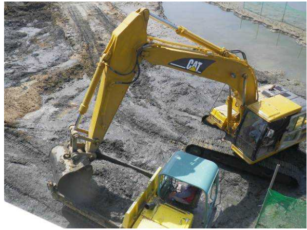
写真 2.2-2 大崎橋右岸地点での掘削の様子 (平成 24 年 7 月 15 日)
