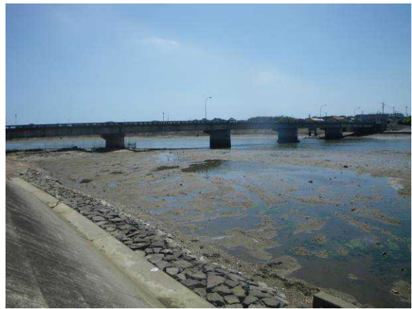
写真 2.2-4 掘削から約 2 週間後の様子 (平成 24 年 8 月 3 日)
