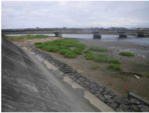
写真 2.2-1 掘削前の大崎橋右岸地点 (平成 24 年 6 月 5 日)
