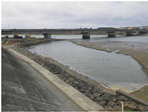
写真 2.2-3 掘削直後の大崎橋右岸地点の様子 (平成 24 年 7 月 15 日)
