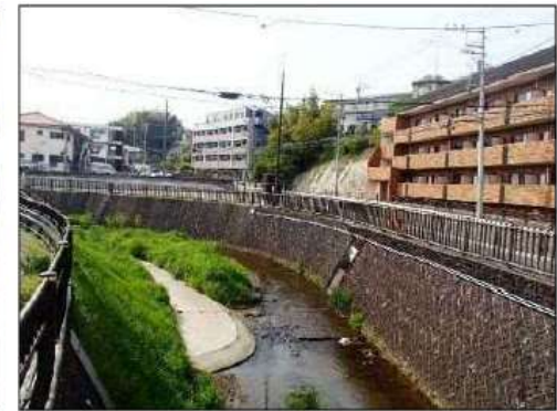
河川改修後の状況(平瀬川支川)
