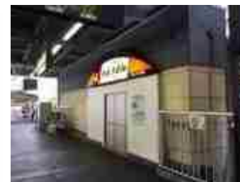
ホーム整備前
