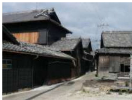
コルタールで黒く塗られた集落民家の壁
