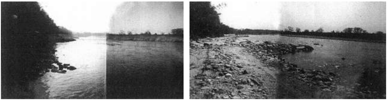
水制工の施工前（左）と施工後（右）の河岸
