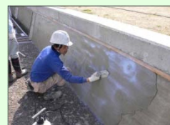
水路の補修・更新
