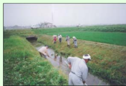
水路の泥上げ
