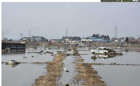
岡田地区冠水した水田
