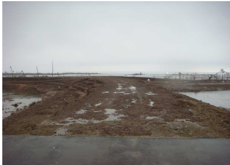
被災状況写真
