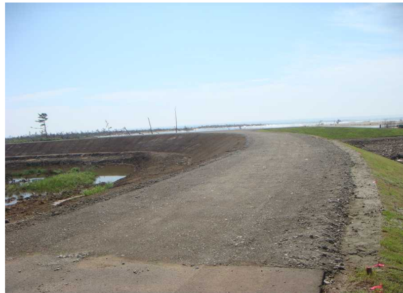
暫定復旧完了写真
