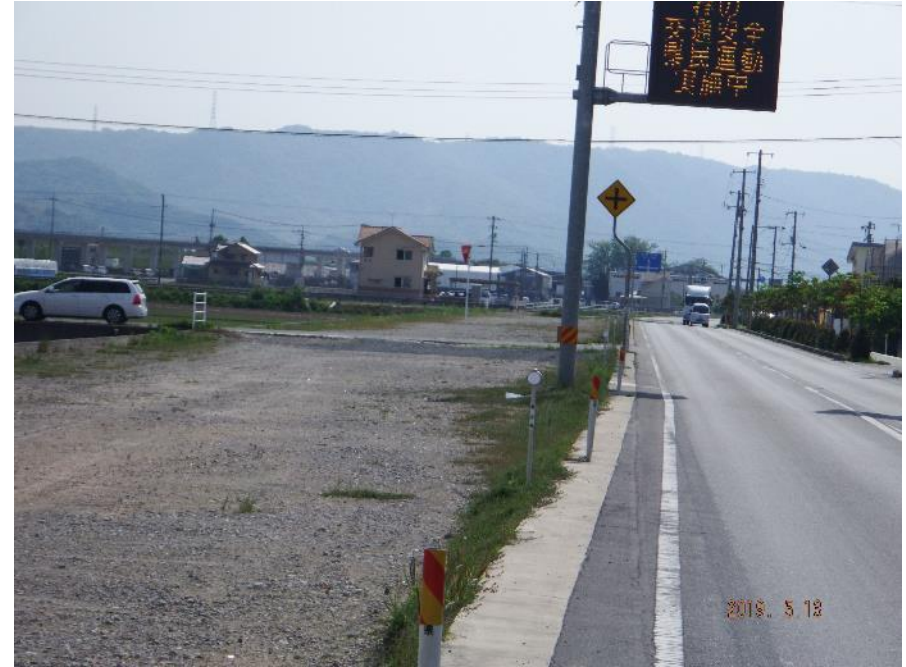
国道486 東西 (撤去後)
