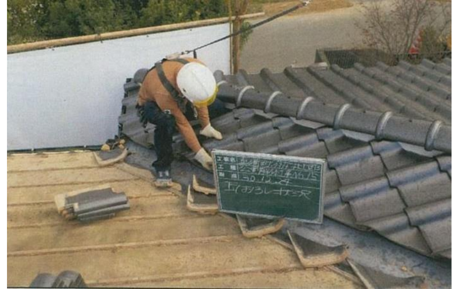
屋根葺き材撤去作業
